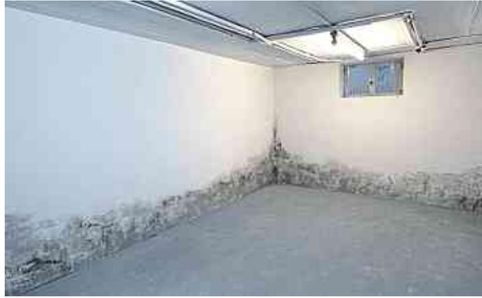
Aus einem feuchten Keller (links) wird nach der Mauerwerksinjektion wieder ein trockener Nutzraum.
