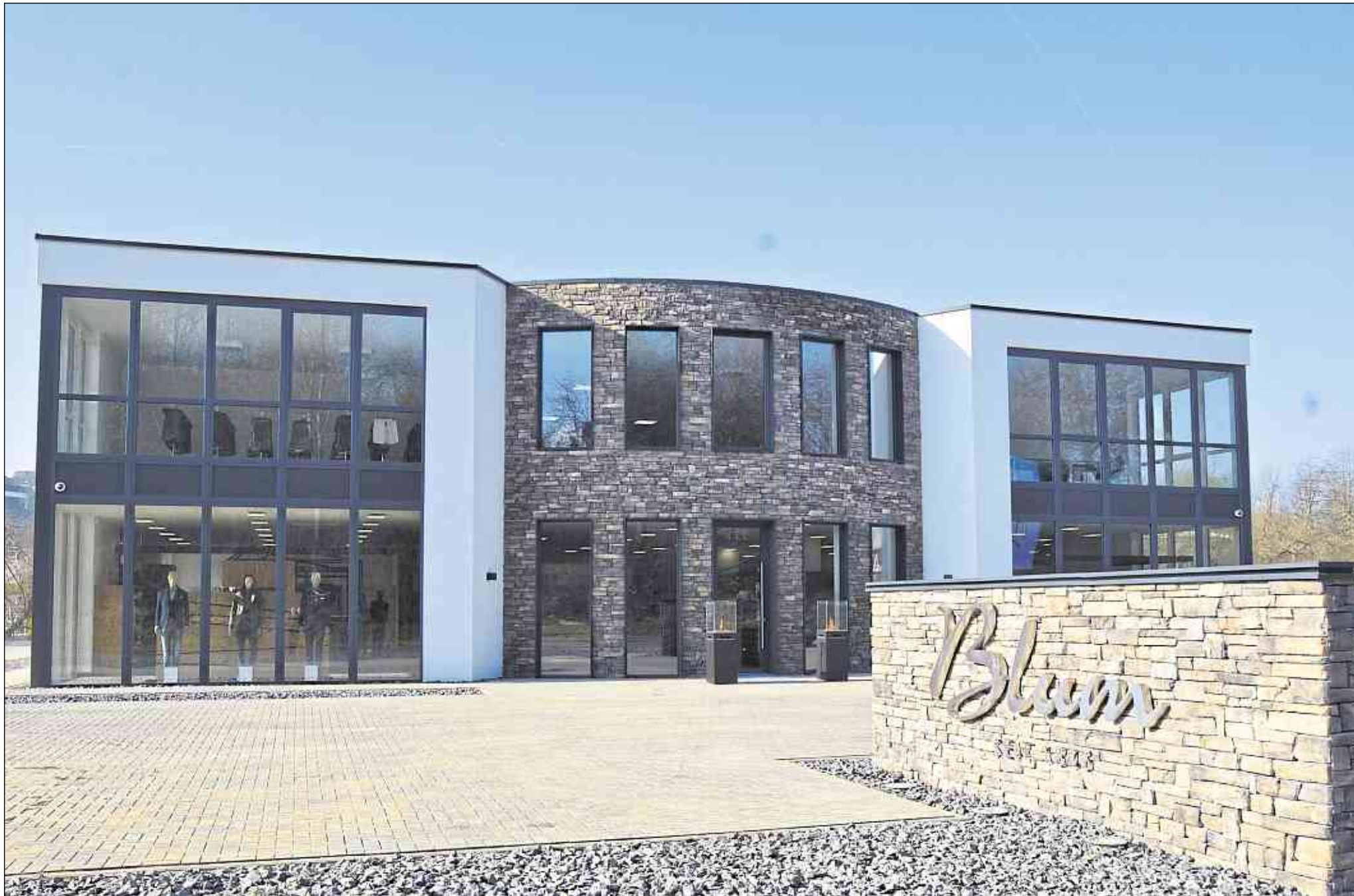
1200 Quadratmeter umfasst der Neubau nahe der Autobahn A 3, der vor der Tür viele Parkplätze bietet. 350 Quadratmeter davon nimmt das moderne Ladenlokal ein.
