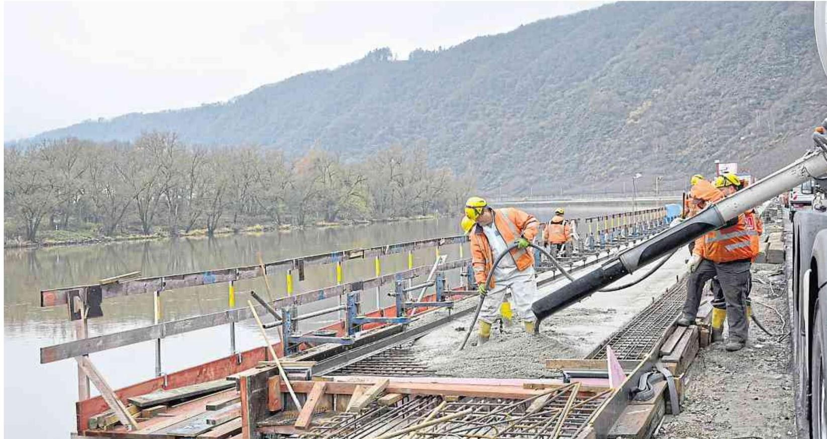
Mitarbeiter des Neuwieder Bauunternehmens Günter Alsdorf fertigen an der B 49 zwischen und Klotten den Betonbalkon über der Mosel an, über den vom Sommer nächsten Jahres an der Moselradweg führen sollen. Der weitere Bauzeitplan ist jetzt stark witterungsabhängig.
