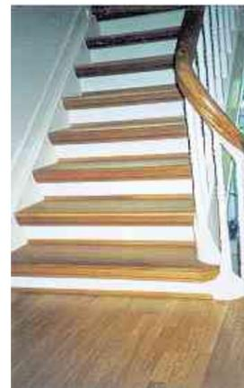
Aus Alt mach Neu: Die alte Treppe wird mit speziell angefertigten Renovierungsstufen neu verkleidet. Foto: Meister Deppe GmbH
