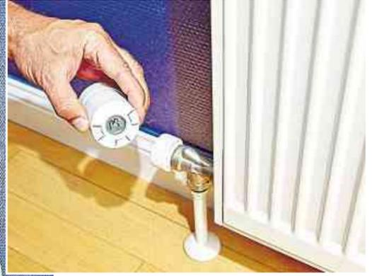
Die modernen Thermostate sind über Adapter mit fast allen gängigen Heizkörperventilen kompatibel und werden direkt am Heizkörper montiert. Foto: djd/Techem/Andreas Böttcher
