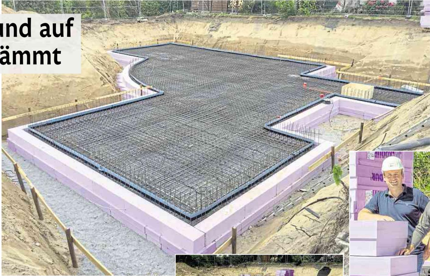
Bodenplatten-dämmung des Eigenheims hat großen Einfluss auf die Energieeffizienz
