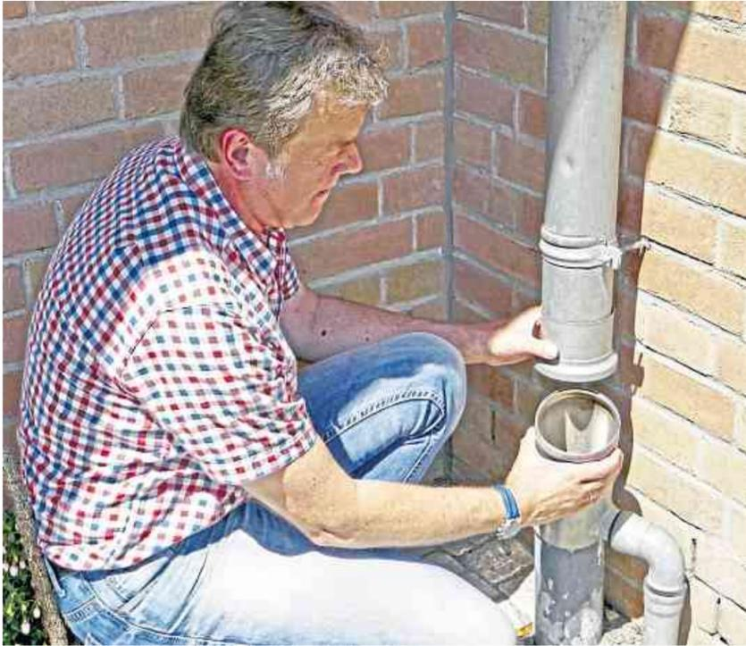
Der Regenwasserfilter im Fallrohr kann einfach entnommen und gereinigt werden.
