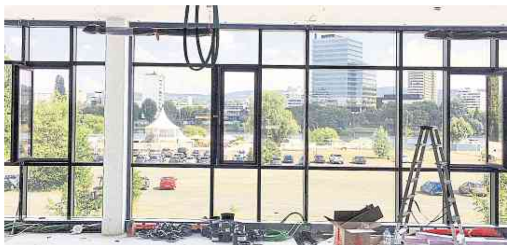
Hier entsteht die neue Arbeitswelt des DICE mit Blick auf die Hauptverwaltung der Debeka auf der anderen Moselseite.
