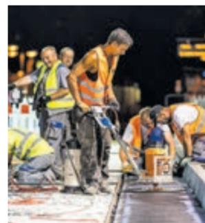
Der neue ingbeton härtet besonders schnell aus und eignet sich damit optimal für zeitknappe Sanierungsmaßnahmen beanspruchter Oberflächen, beispielsweise im öffentlichen Verkehr oder während laufender Produktion.
