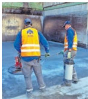
Die Augel GmbH ist zertifizierter Einbauer für den neuen ultrahochfesten Betonboden. Der Industrieboden mit minimal niedrigem Aufbau von 46 mm und fugenarmen Flächen kann auf allen tragenden Untergründen eingebaut werden.
