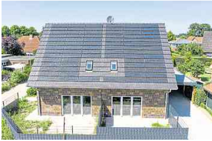
Von der Wärmedämmung der Fassade bis zur Solaranlage auf dem Dach. Foto: djd/dachdeckerdeinberuf.de/Nelskamp/Schoening
