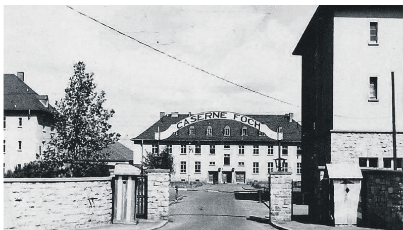
Die Kaserne in der Alzeyer Straße als Caserne Foch der Franzosen bzw. Rose Barracks der US-Army.
