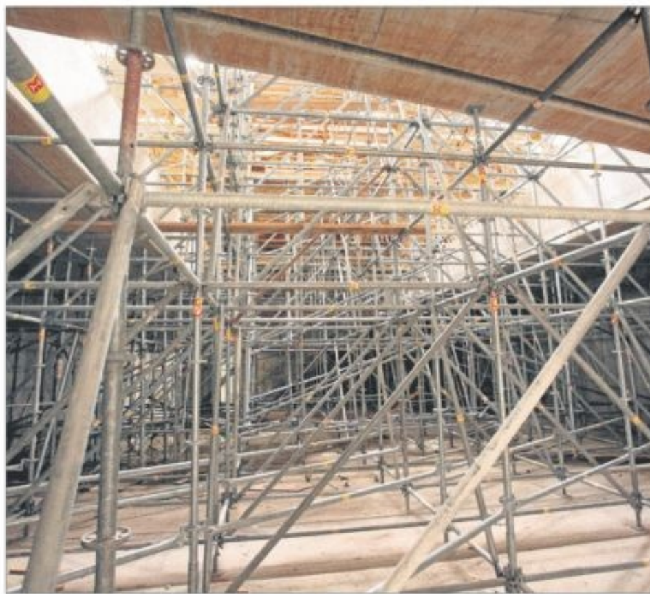
Gerüststangen prägen momentan das Bild im Inneren der künftigen Synagoge und der anderen Räume. Schon jetzt ist die Offenheit erkennbar, die das gesamte Projekt nach außen und innen haben wird. ■ Foto: Harry Braun
