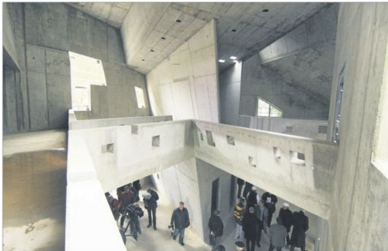
Blick ins Innere des Rohbaus: In der künftigen Mainzer Synagoge gibt es kein Objekt zweimal. Die Firmen Gemünden und Karrié haben den Entwurf von Architekt Manuel Herz baulich perfekt und unfallfrei umgesetzt. ■ Foto: Michael Bellaire
