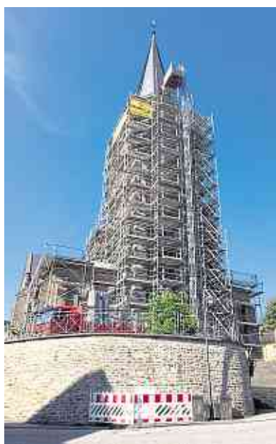
Das Gerüst am Kirchturm von St. Ignatius in Betzdorf ist nicht mehr verhüllt. Foto: Andreas Neuser
