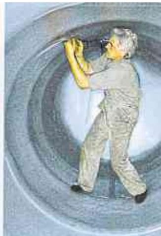
Nach einer fachmännischen Tankreinigung werden eine Kunststoff-Innenhülle eingebaut und die erforderlichen Anschlüsse montiert.
