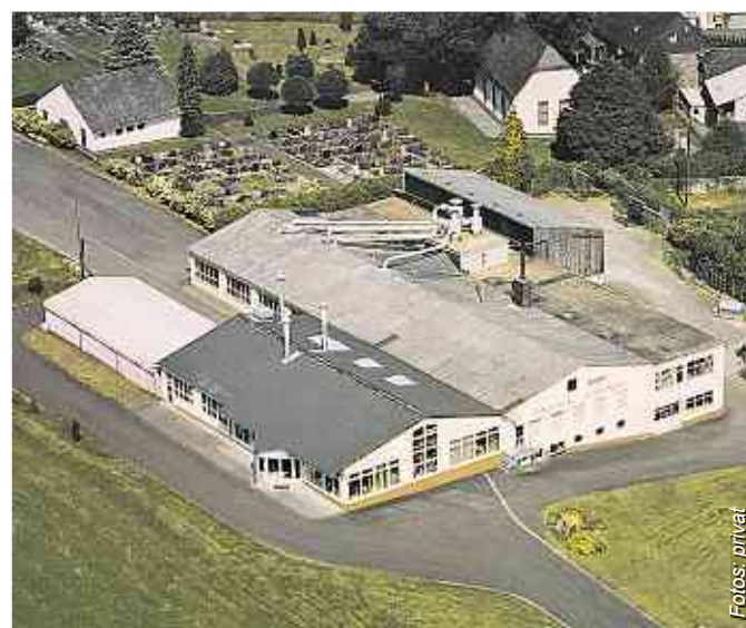
... und wurde ständig erweitert. Die Halle im oberen Schwarz-Weiß-Foto stellt den rechten Gebäudebereich im unteren Bild dar, die Anbauten links kamen 1970 und 1981 dazu.
