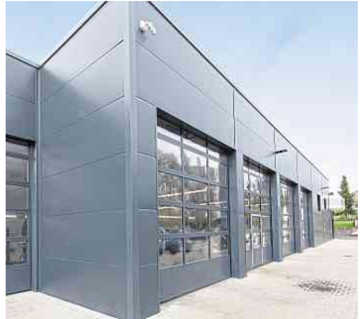
Moderne Industrietore – wie hier bei Hottgenroth & Farrenberg in Hachenburg – sind das Kerngeschäft von B2K Tortechnik.
