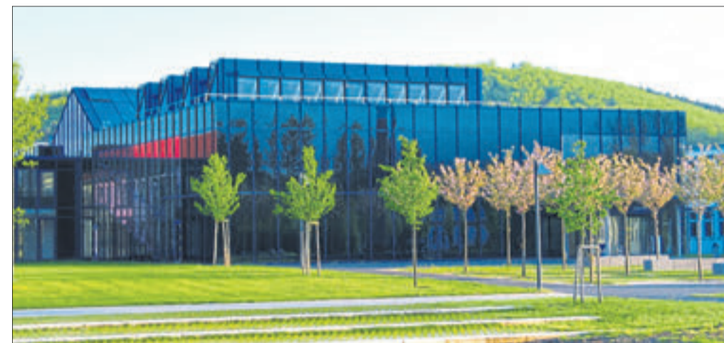
Das 2001 eröffnete Zentralgebäude auf dem Umwelt-Campus Birkenfeld. Der gesamte Campus ist als „Zero-Emissions-Campus“ konzipiert.
