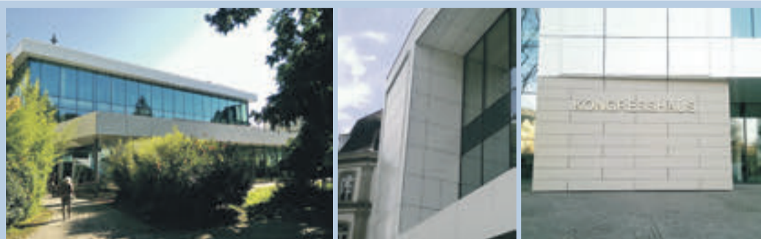
Kongresshaus in Baden Baden – Alucobond-, Glattblech-, Eternitfassade (2014/2015)
