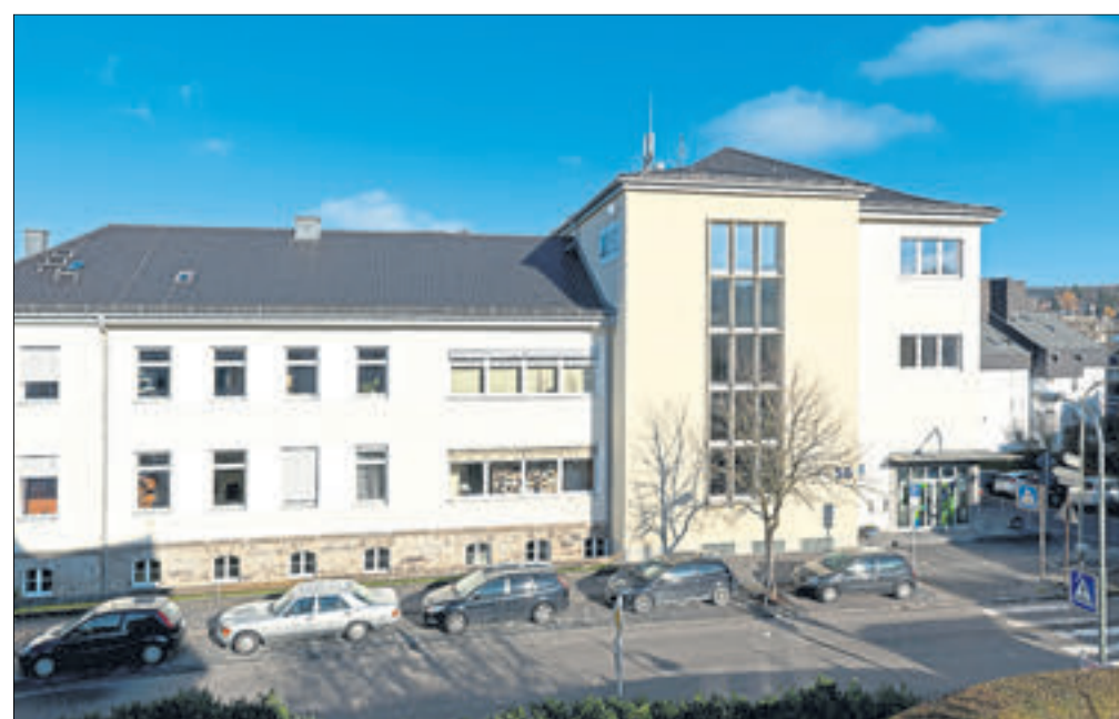
Der WesterWaldCampus in Höhr-Grenzhausen.
