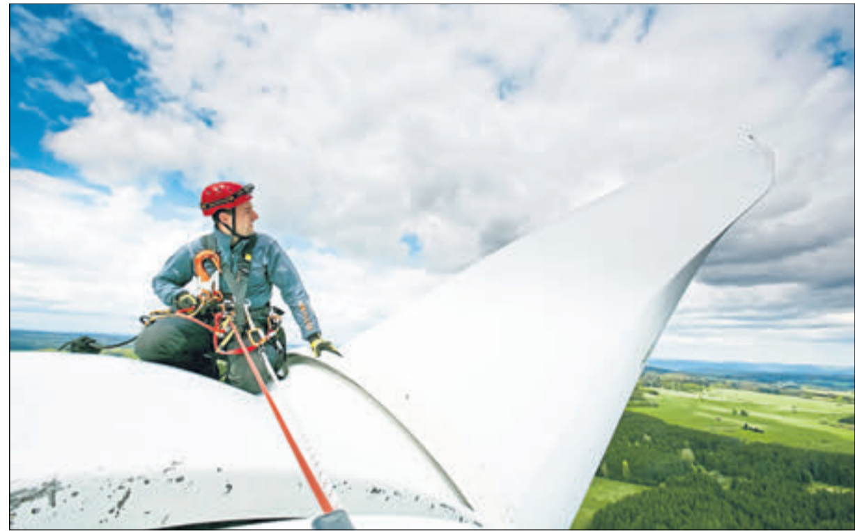
Bestens gesichert: Bei der Arbeit an Windenergieanlagen geht man besser auf Nummer sicher. Absturzsicherung ist in bis zu 150 Metern Höhe keine Frage des Wollens.
