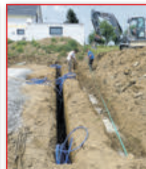
Erdwärmanlagenbau Vorteile: geringe Einbautiefe & schmale Gräben, meist genehmigungsfrei!
