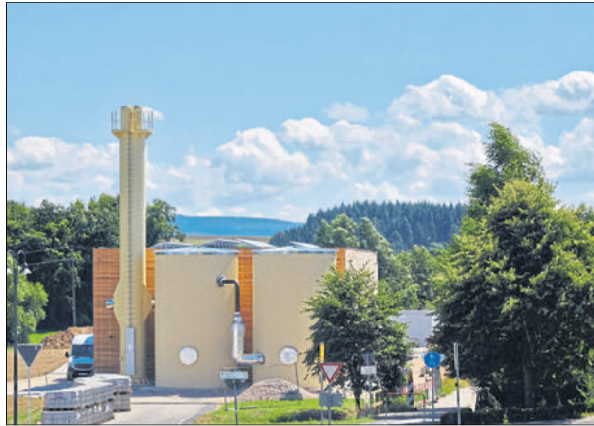
Mehr als 140 Betriebe und Haushalte, über sechs Kilometer Leitung: Die Verbandsgemeinde Simmern beheimatet die größte solar-thermisch unterstützte Nahwärmeversorgung in Rheinland-Pfalz. Auf dem Bild: das Heizwerk.
