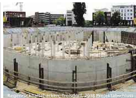
Regenrückhaltebecken, Troisdorf, 2018 Projektabschluss
